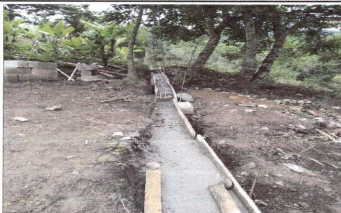
Mejoramiento de muro perimetral
