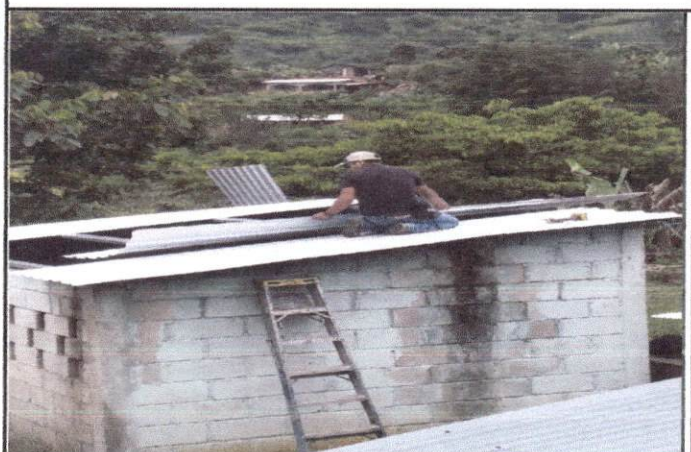
Mejoramiento de techo de cocina
