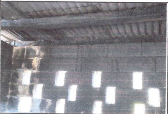
Mejoramiento de la pared de cocina
