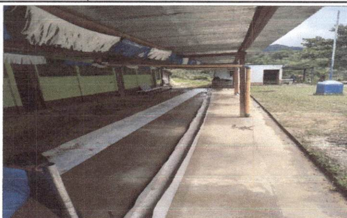
Mejoramiento de canales
